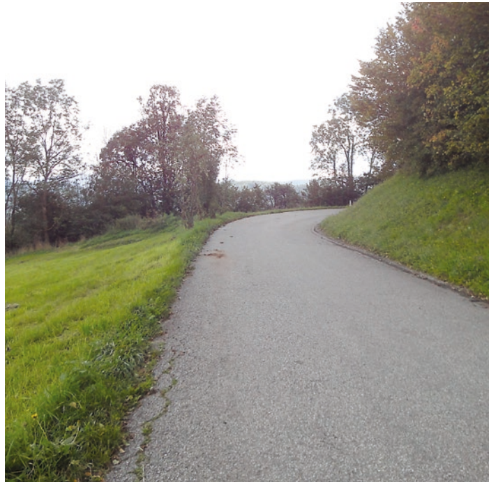
Unübersichtliche Kurve Putzenbergweg.
