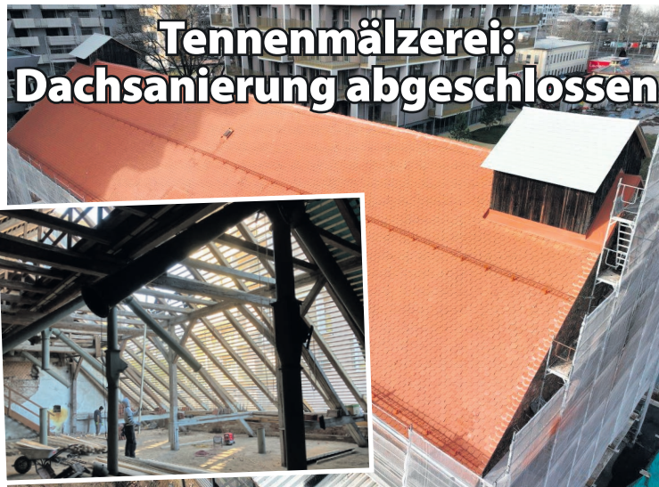
Nach Unwetterschäden wurde das Dach der Tennenmälzerei vollständig saniert.
