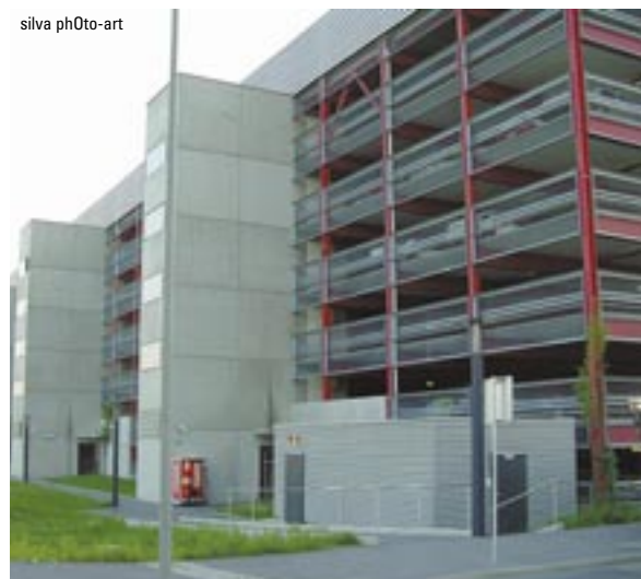
Ohne Vorwarnung: Arbeiter standen vor verschlossenen Parkhaus-Türen.
