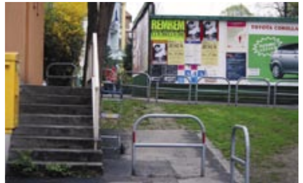
KPÖ-Geidorf fordert die Sanierung des Durchganges Körösistraße zur Fischergasse.
