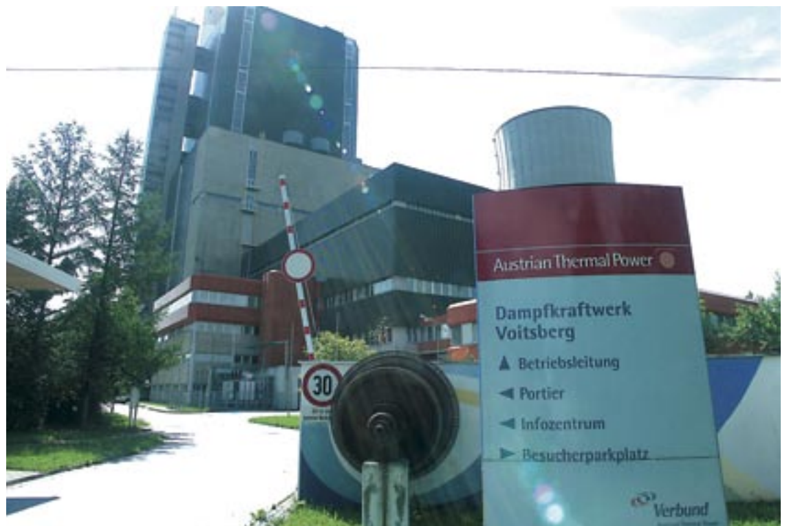
Das Voitsberger Kohlekraftwerk soll wieder aktiviert werden.
