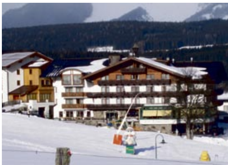
Hopsi, der Hase in der Bildmitte und Maskottchen der Schi-WM 1982 in Schladming-Rohrmoos, hat ausgedient.
