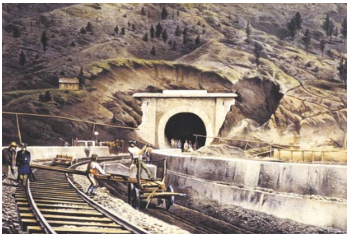
Nach nur sechsjähriger Bauzeit wurde die Semmeringstrecke 1857 eröffnet. Es war eine Pionierleistung. Am Semmeringtunnel plant man nun schon 30 Jahre.
