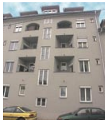
Mauergasse 27-29 und 35-39: Erbaut 1928, 33 Wohnungen, umfassend saniert 2003 bis 2007.
