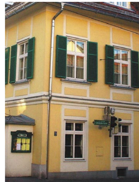
Foto ganz links: Städtisches Wohnhaus Moserhofgasse 17, erbaut 1898, saniert 2007.
