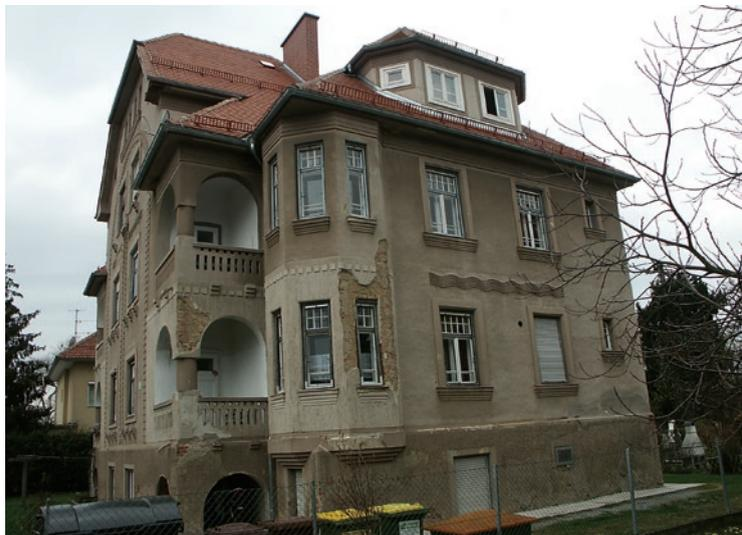
**Vor der Sanierung:** Der Putz bröckelte, die Wände waren feucht, die Fenster waren undicht – eine Sanierung war dringend notwendig.
