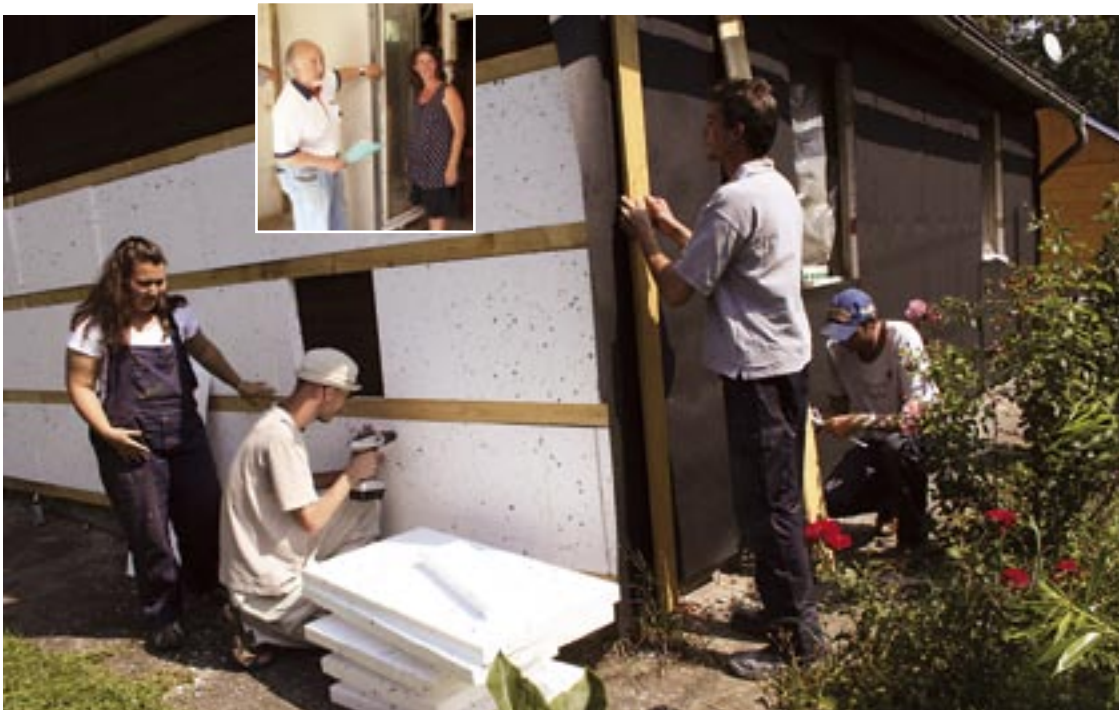
Projekt des Österreichischen Bauordens: Holzhaus in der Theyergasse 4 wurde ehrenamtlich saniert.
